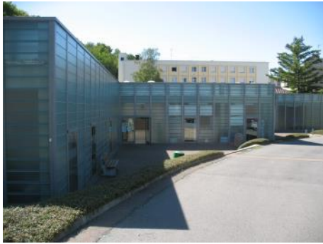
Bâtiments D, E, H - Halles GCE, Pharma et Agro 1500 m 2
